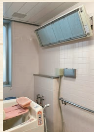
脱衣所に暖房、浴室には電熱ヒーターを設置。温度差によるヒートショックを防ぐ工夫をしています。
